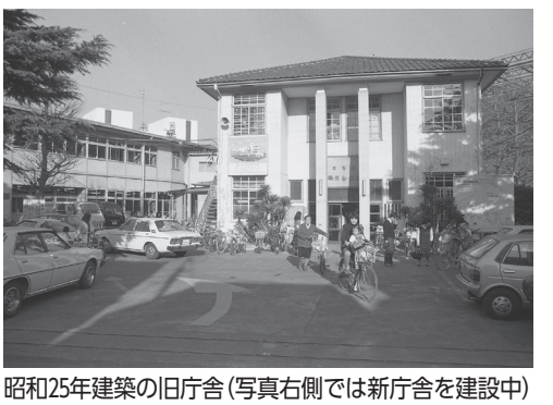
昭和25年建築の旧庁舎（写真右側では新庁舎を建設中）
