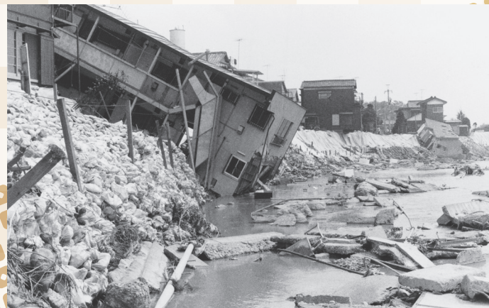
昭和49年 多摩川堤防決壊。民家19戸が流出した
