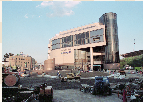
平成7年 狛江駅北口市街地再開発途中の様子
